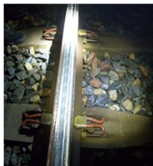
Rail après meulage
