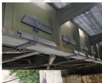
Absorbeur sur platelage
