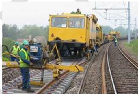
Longs Rails soudés sur traverses béton
